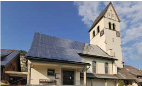
Evangelische Bergkirche mit Photovoltaik in Schönau
