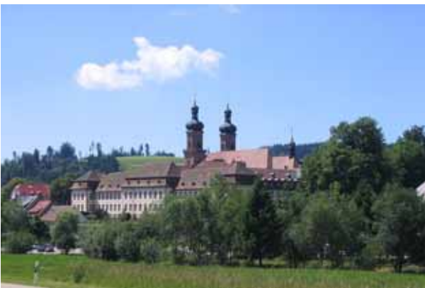
Energieautonom: St. Peter im Hochschwarzwald
